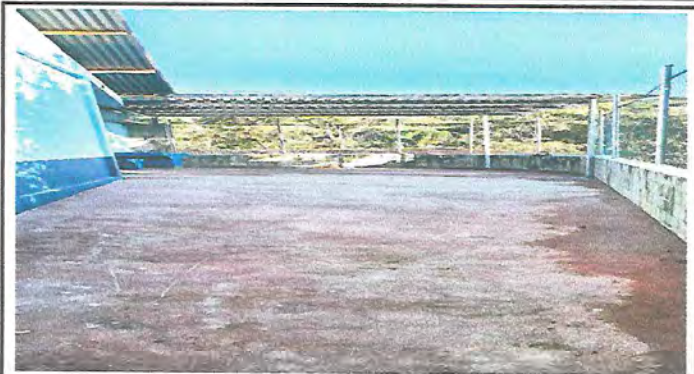
Foto 2: FUNDICIÓN DE LOSA DE PATIO
