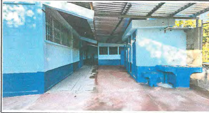
Foto 1: FUNDICIÓN DE LOSA DE PATIO
