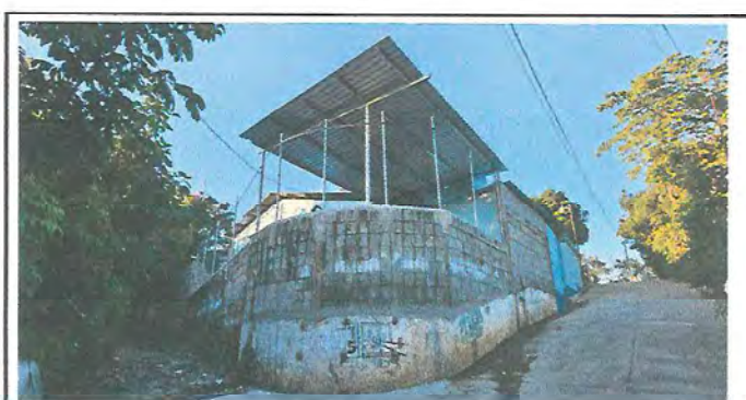
Foto 6: TECHO DE PATIO
