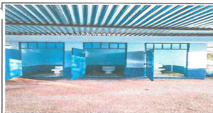
Foto 5: SUSTITUCION DE BAÑOS
