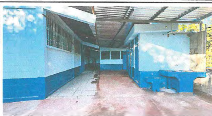
Foto 2: APLICACIÓN DE PINTURA GENERAL
