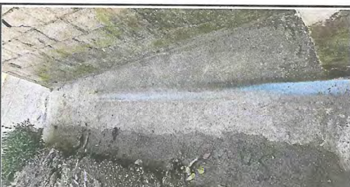
Foto 4: FUNDICION DE BANQUETA
