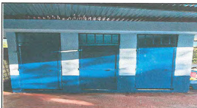
Foto 4: REMOZAMIENTO DE PUERTAS DE BAÑOS
