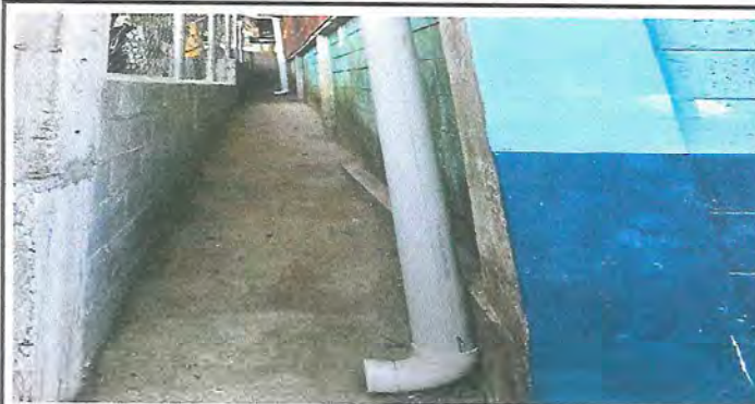
Foto 3: FUNDICION DE BANQUETA
