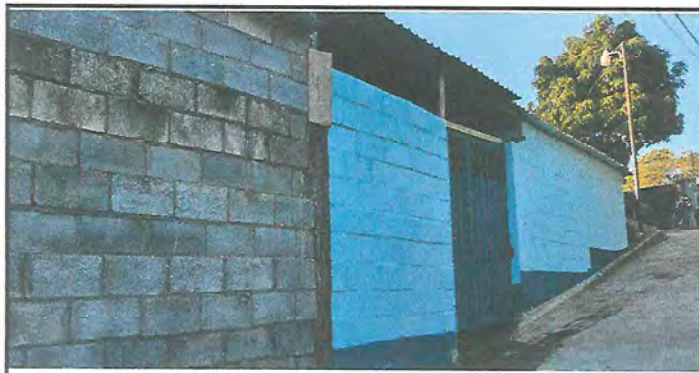
Foto 3: APLICACIÓN DE PINTURA GENERAL
