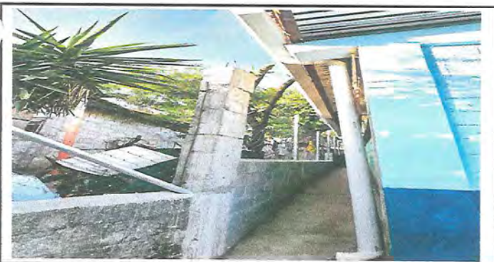
Foto 5: LEVANTADO DE MURO CON MALLA METALICA
