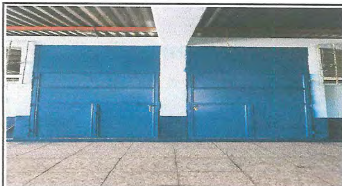
Foto 3: REMOZAMIENTO DE PUERTAS DE AULA
