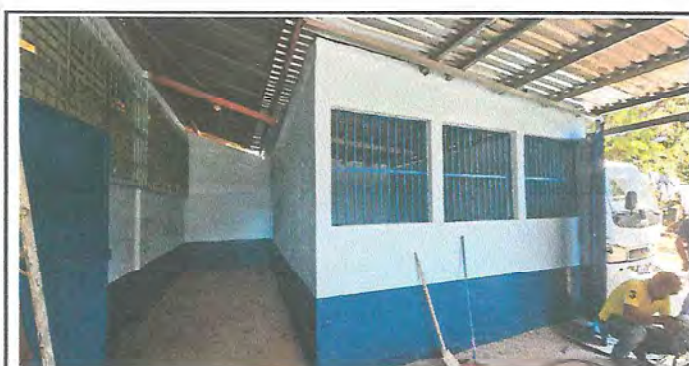
Foto 6: SUSTITUCION DE BALCONES
