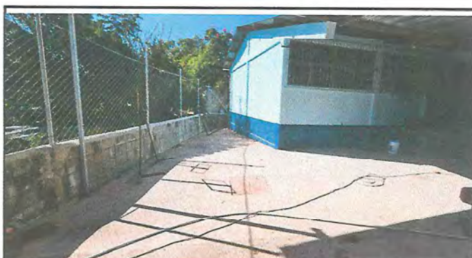
Foto 4: APLICACIÓN DE PINTURA GENERAL
