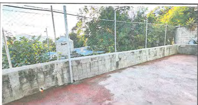
Foto 6: SUSTITUCION DE MALLA METALICA
